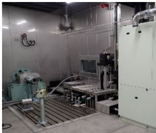
エンジン試験設備
